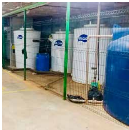
Foto 3.1. Sistema de tratamento de água cinza
